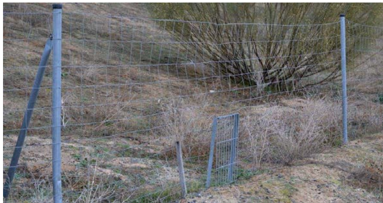
Figura 7: Representación de pasos a ras de suelo en un vallado.
